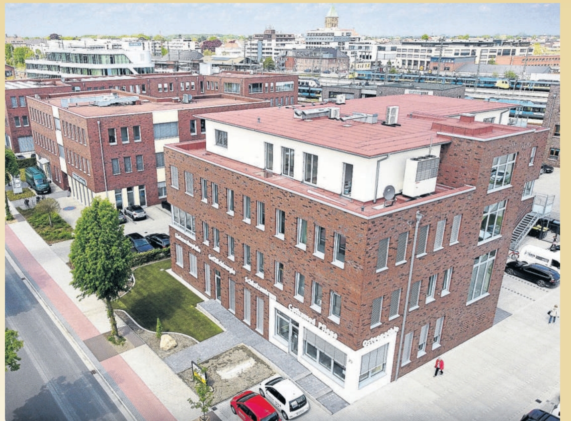
Das vierte Einsteinhaus (vorne rechts) mit seiner klassischen Klinkerfassade fügt sich nahtlos in das bereits bestehende Ensemble der anderen drei Einsteinhäuser im Innovationsquartier am Bahnhof ein. Fotos: Sven Rapreger
