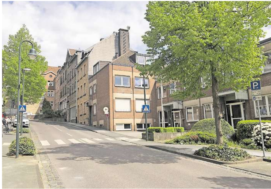
Das alte Rolandshaus - auf einem Areal von rund 2100 Quadratmetern soll nach dem Abriss das neue Rolandshaus Gesundheitszentrum Stolberg entstehen. FOTO: GROSCHEK IMMOBILIEN GMBH
