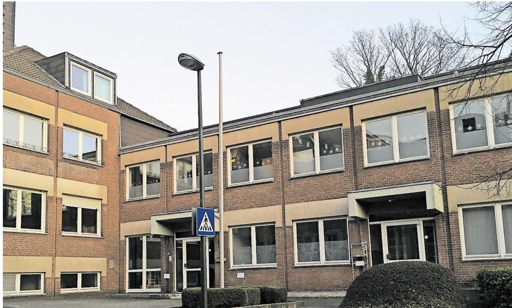
Neubau geplant: Das Rolandshaus soll es in dieser Form bald nicht mehr geben. FOTO: SONJA ESSERS
